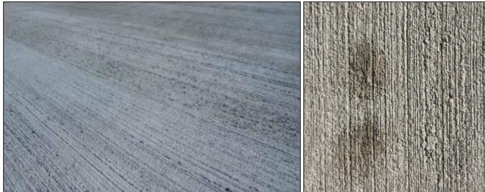
2 pav. Betono paviršius brauktas šepėčiu
